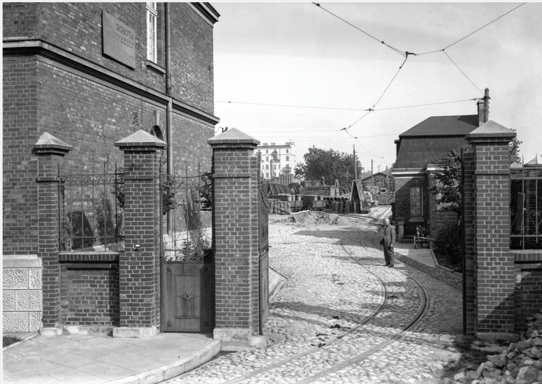
Brama wjazdowa na teren Działu Gospodarczego przy ul. Wierzbowej 52, po 1930 r.
