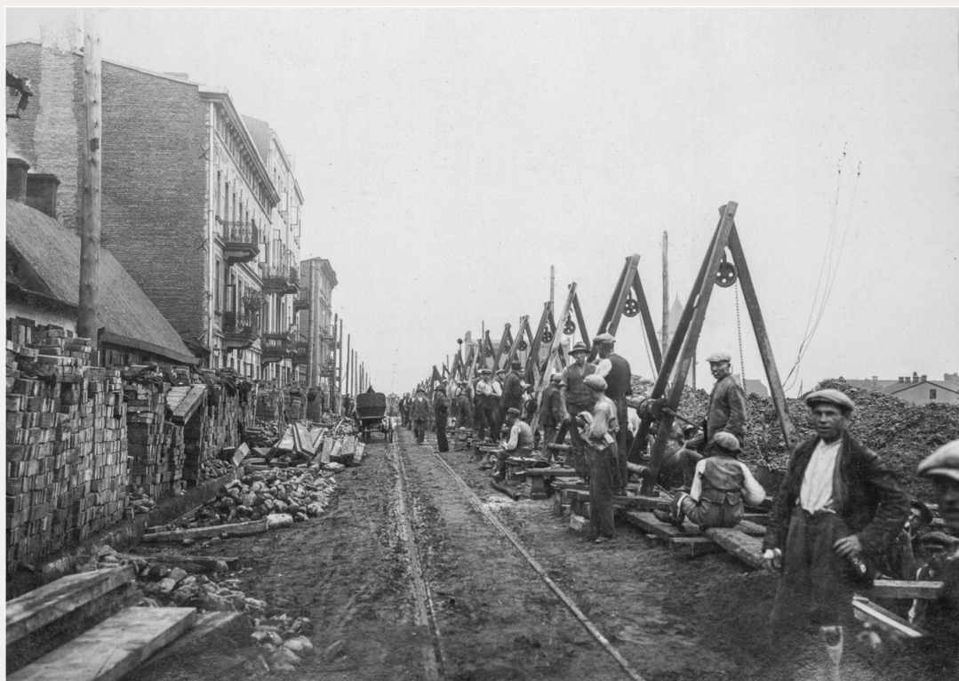
Budowa kanału J 4 90x160 w ul. 11 Listopada (dziś ul. Legionów; nr 142-150), wrzesień 1928 r.
